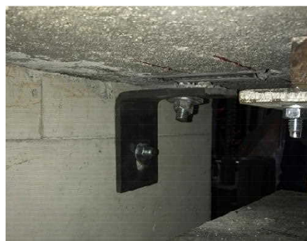
j) Parafuso expulso do canal CPC_O_14
