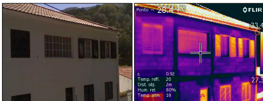
Fig. 2 – Imagem da fachada principal, à esquerda, e respetivo registo termográfico, à direita.
