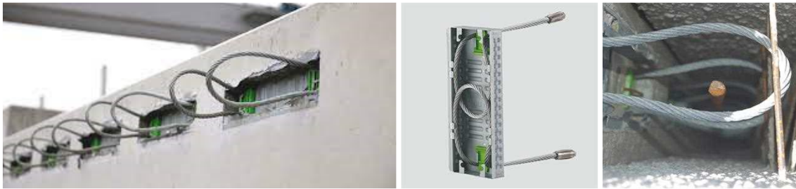
Fig. 7 – Pfeifer VS Slimbox na interface entre painéis de laje CREE.
