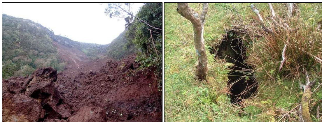
Fig. 4 – Vista geral da cicatriz do movimento ocorrido em 2003 (à esquerda) e fendas encontradas no terreno (à direita).
