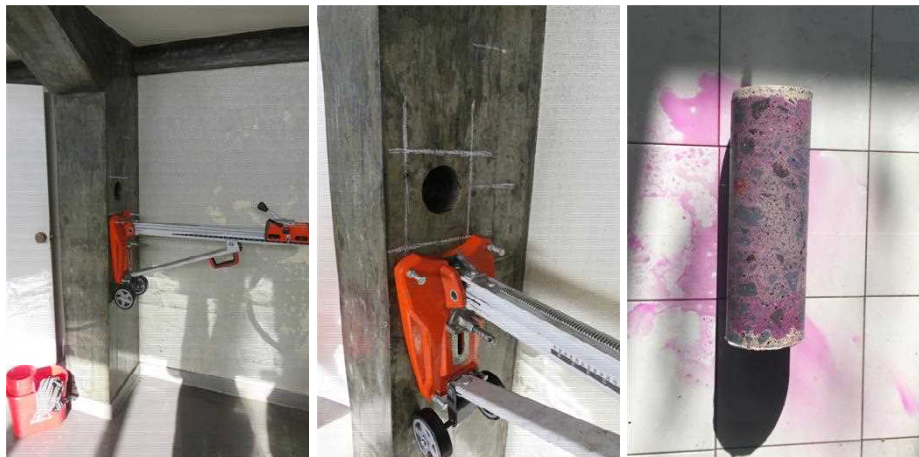
Fig. 8 – Extração de carote a meia altura de pilar (à esquerda e ao centro); Ensaio de fenolftaleína (à direita).
