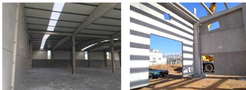
Figura 2 - Edifícios do parque industrial português com painéis de fachada horizontais.
