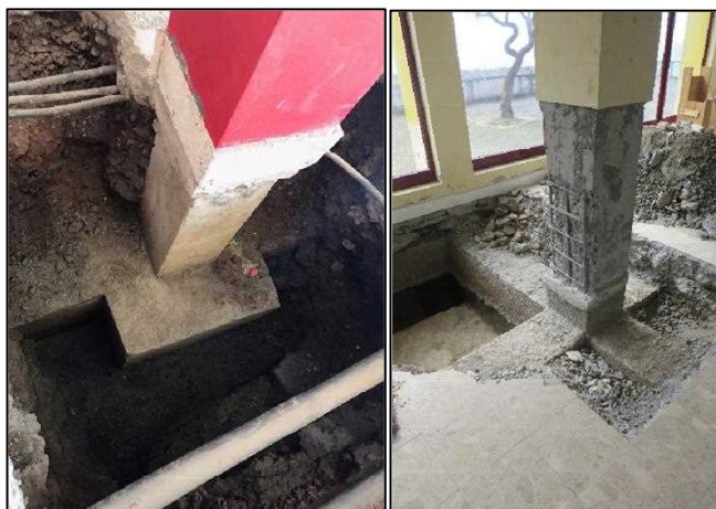
Fig. 3 – Poços para observação direta de fundações.
