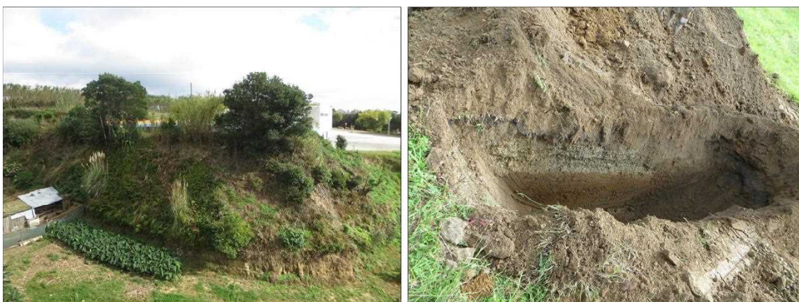
Fig. 3 – Vista geral do talude e dos materiais ocorrentes.
