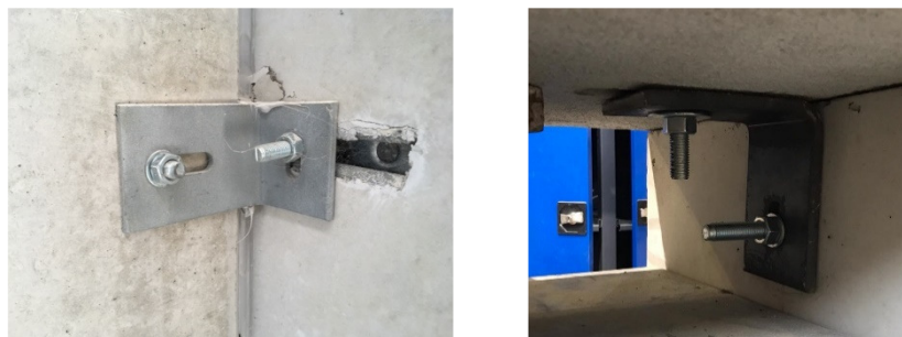
Figura 1 - Ligação painel-pilar habitualmente utilizada em Portugal.
