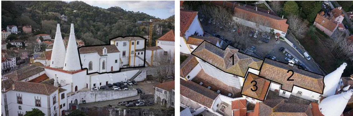
Fig. 3 - Vistas das unidades do agregado em estudo.
