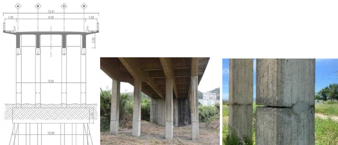
Fig. 12 – Pilares intermédios das subestruturas dos viadutos com montantes articulados.
