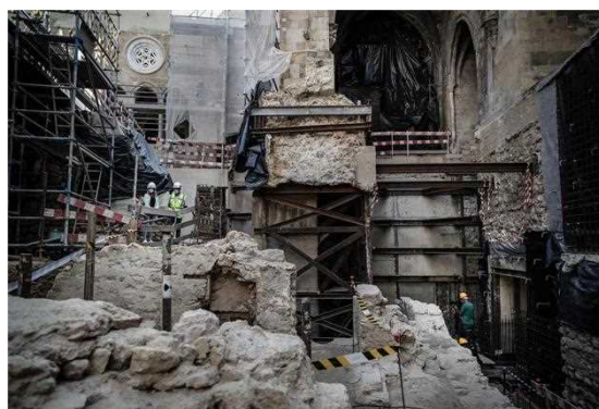
Figura 1 – Troço sul do claustro da Sé Patriarcal de Lisboa (a vermelho na planta à esquerda) e do arco de extremidade (a azul); fotografia da contenção provisória do arco de extremidade na situação de interrupção da empreitada (direita) (Fonte: Gepectrofa)
